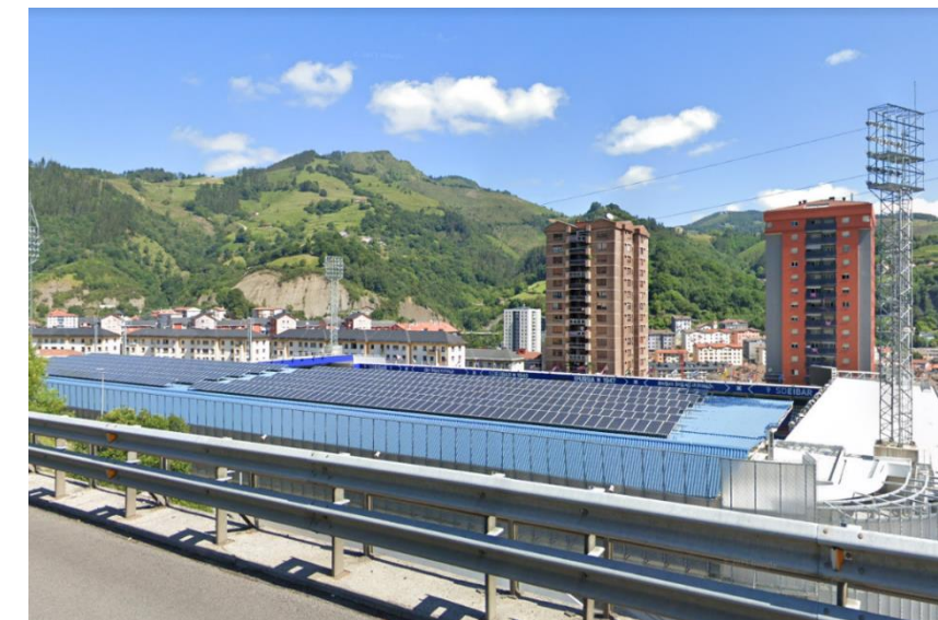
Paneles solares. Estadio Municipal de Ipurua
