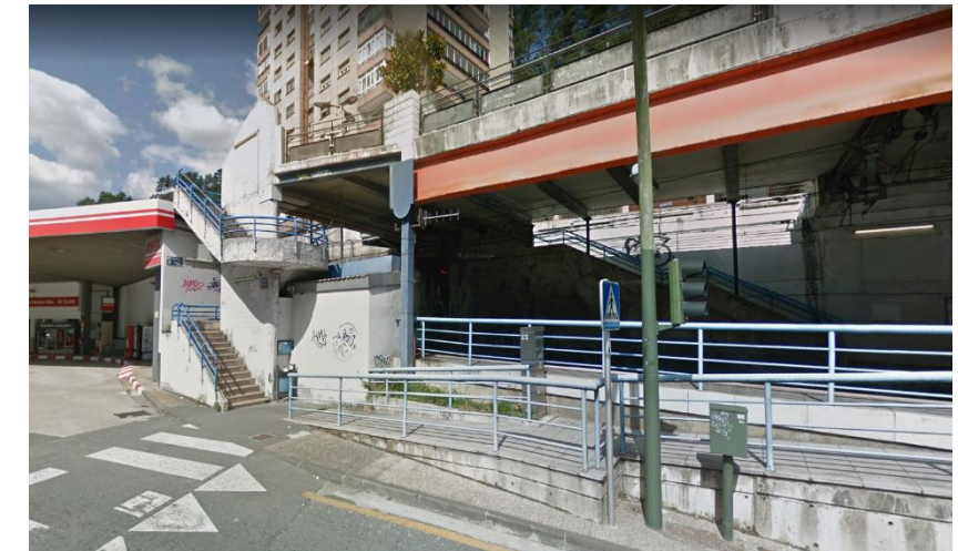
Estación de la Universidad
