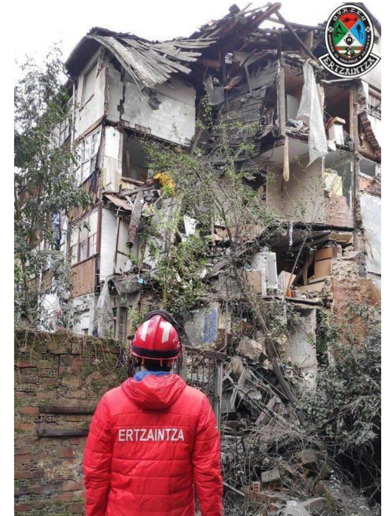
Imagen de edificio residencial derrumbado en Arragueta. Fuente: Noticias de Gipuzkoa (Ertzaintza)
